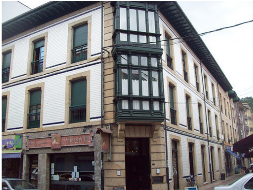
Edificio entre las calles Balbín Busto y Malayo, junto al mercado municipal
