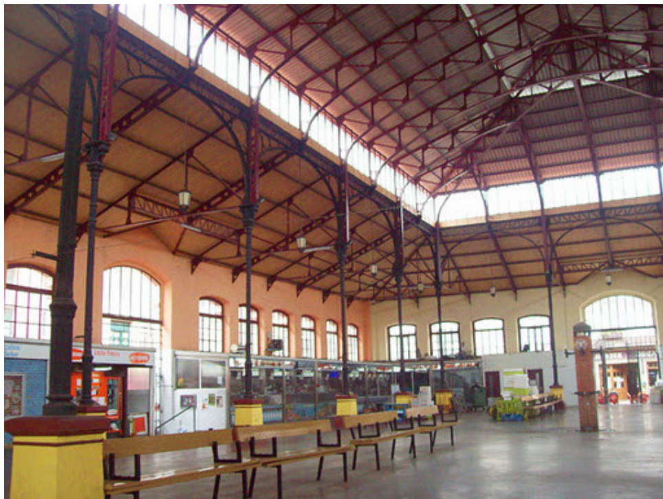
Plaza de Abastos o Mercado municipal. Arquitectura del hierro y los espacios diáfanos
