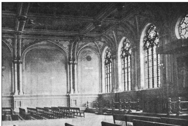
Fig. 6. Interior del salón de actos del Seminario de Santo Tomás. (Fotografía de Santamaría, Luis Bellido, La Construcción Moderna , 1905)
