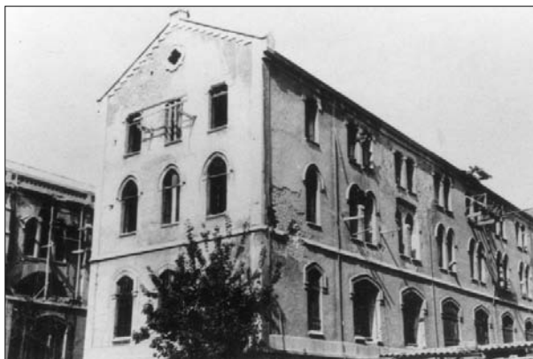
Fig. 3. 1938, proceso de reconstrucción del Cuartel del Milán, antes Seminario Conciliar. Pabellón segundo por el este y primitiva iglesia. (Fotografía del Archivo General del Principado de Asturias).
