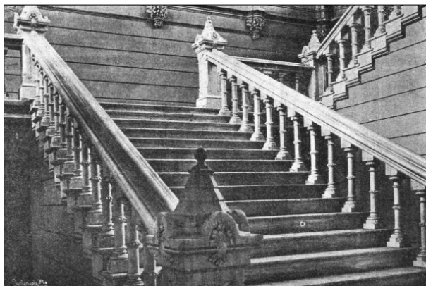
Fig. 4. Escalera principal del Seminario de La Vega. Fotografía de Santamaría, publicada por Luis Bellido en La Construcción Moderna , 1905.
