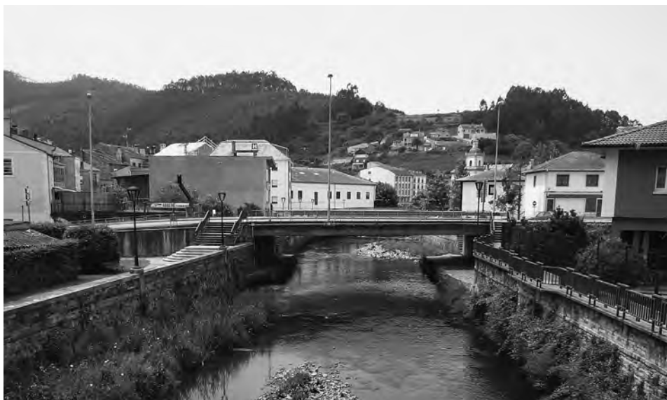
FIG. 2. Herminio: Rotura en el espacio (2006). Puente de Reguera.
