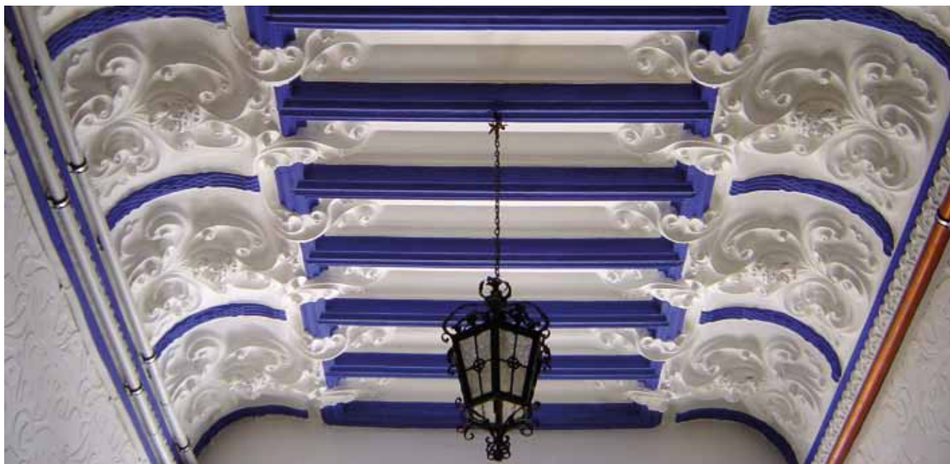
FIGURA 143: Techo del portal.
