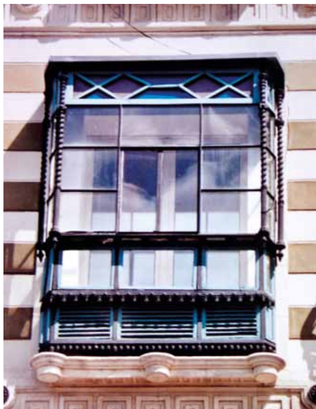
FIGURA 160: Detalle de la fachada.
