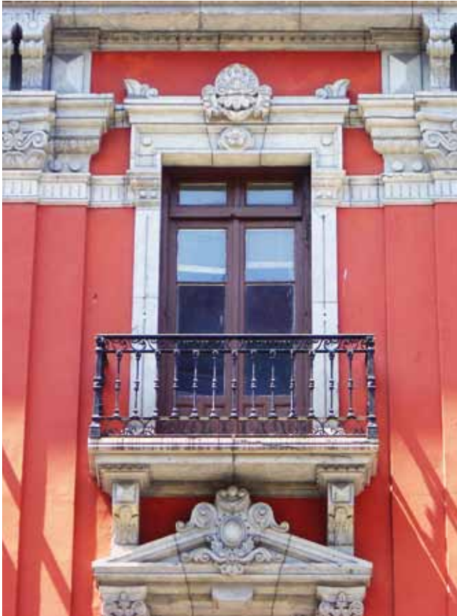
FIGURA 414: Detalle de la fachada.
