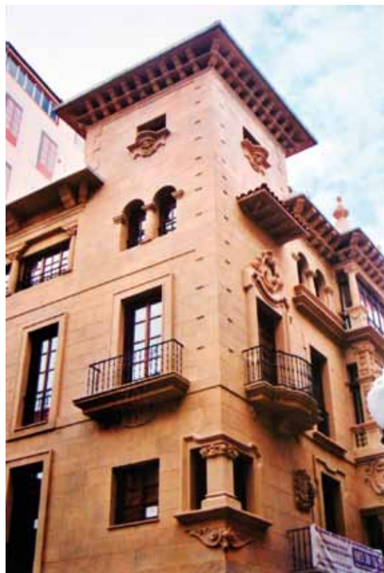
FIGURA 444: Detalle de la fachada.
