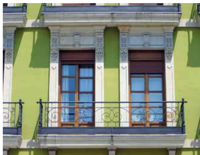
FIGURA 251: Detalle de la fachada.
