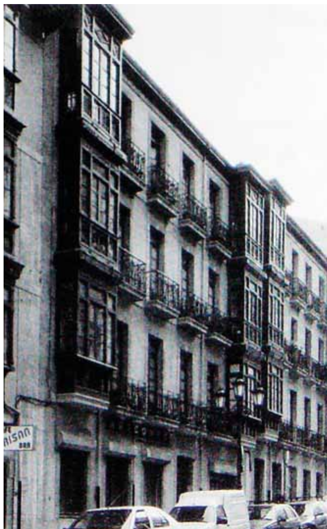
FIGURA 295: Estado en la década de 1980.
