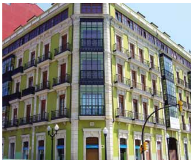
FIGURA 250: Estado actual del primer edificio.
