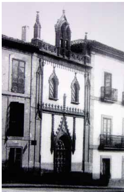
FIGURA 320: Capilla de Los Remedios, Cimadevilla, Gijón. (R)
