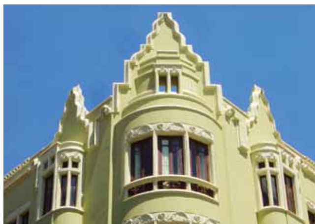
FIGURA 141: Detalle de la fachada.
