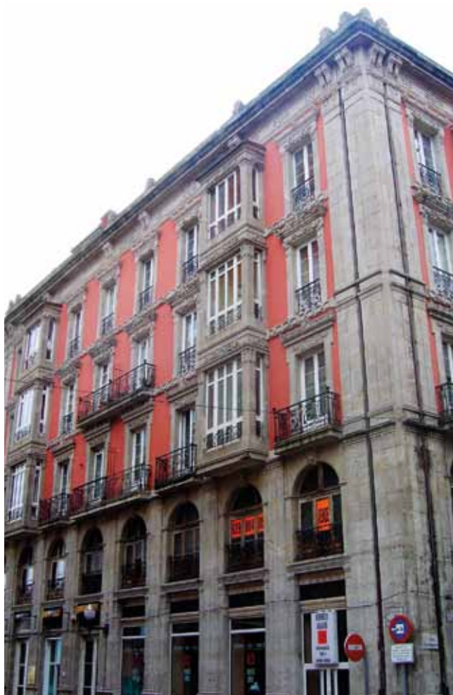
FIGURA 197: Estado actual de la fachada a la calle Julio Somoza.
