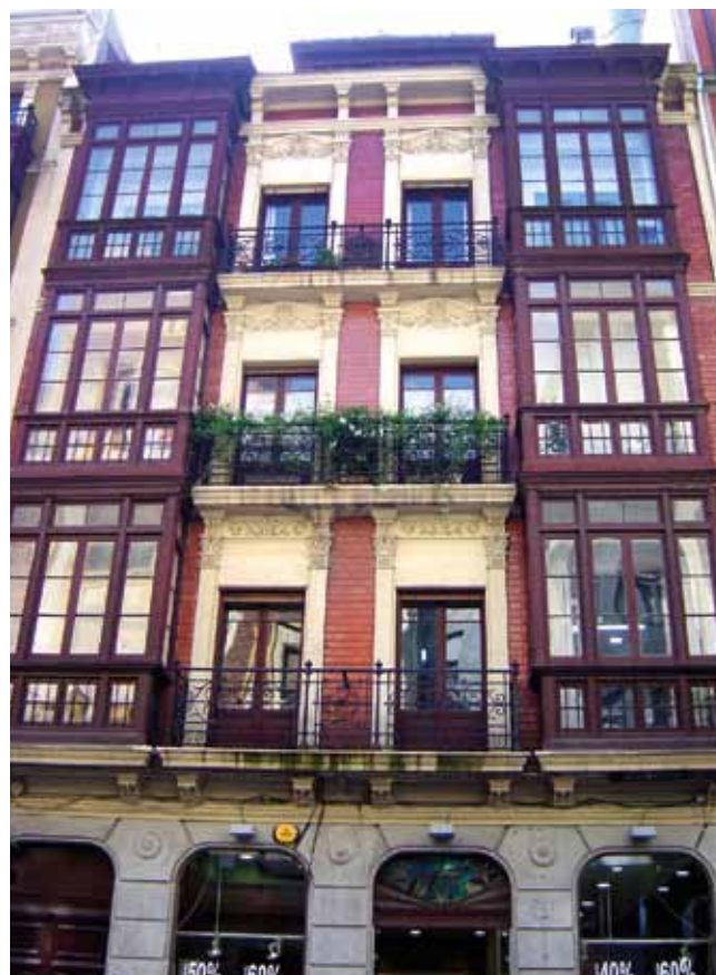
FIGURA 123: Edificio de viviendas en la calle Fray Ceferino, Oviedo. Maestro de obras Ulpiano Muñoz.
