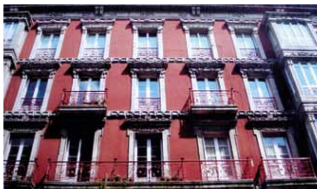
FIGURA 198: Detalle de la fachada a la calle San Bernardo.
