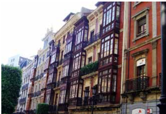
FIGURA 351: Serie de edificios de viviendas en la calle Fray Ceferino, Oviedo.
