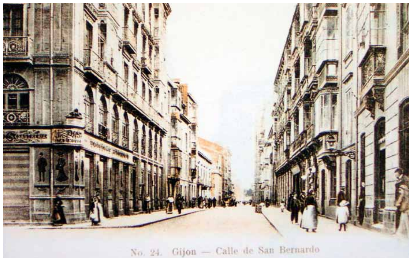
FIGURA 93: Tramo inicial de la calle San Bernardo, dominado, a izquierda y derecha, por inmuebles del maestro de obras Pedro Cabal. El edificio que se adivina al fondo a la izquierda, sede de la ferretería Gregorio Alonso, es obra del también maestro Pedro Cuesta.
