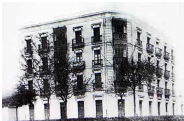
FIGURA 249: Segundo edificio de José Las Clotas, plaza de Europa esquina a calle Covadonga, Gijón. (R)
