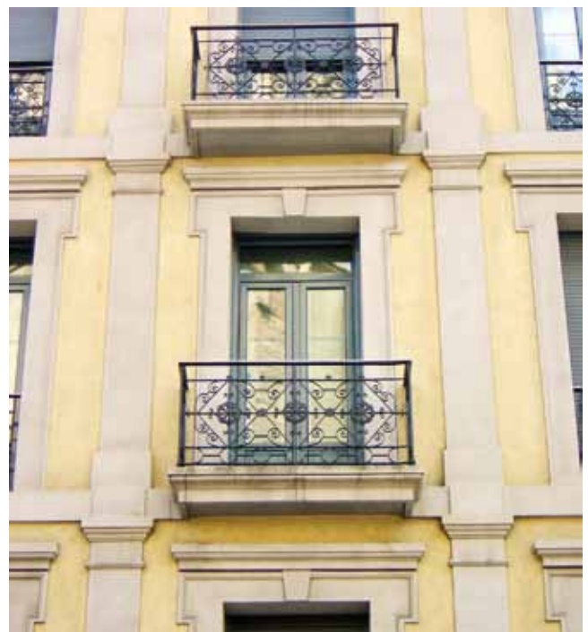
FIGURA 338: Detalle de la fachada.
