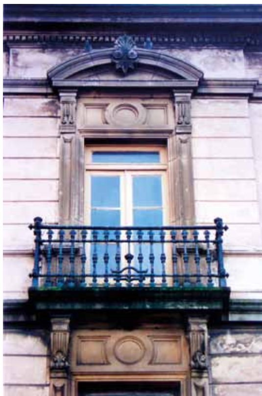
FIGURA 188: Detalle de la fachada.
