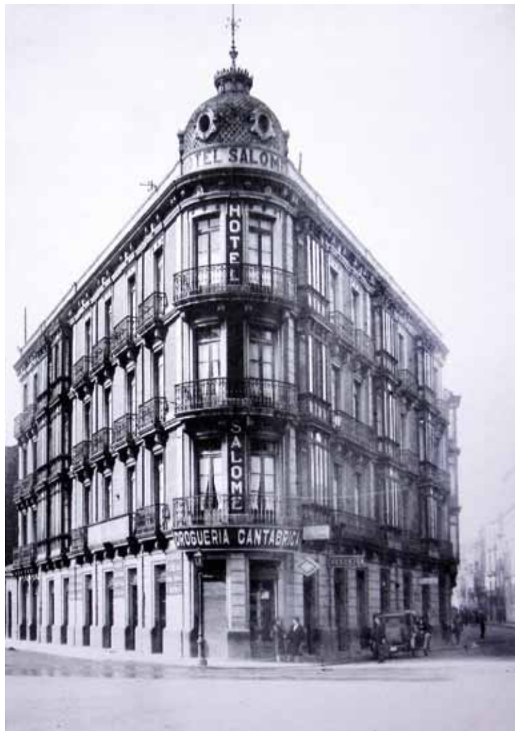
FIGURA 202: Edificio del hotel Salomé, calle Álvarez Garaya esquina a la del Carmen, Gijón. (D)
