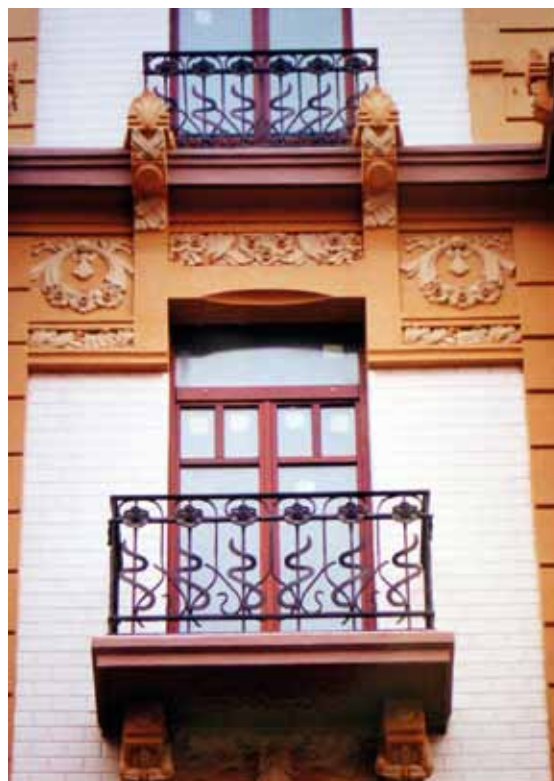
FIGURA 437: Detalle de la fachada.
