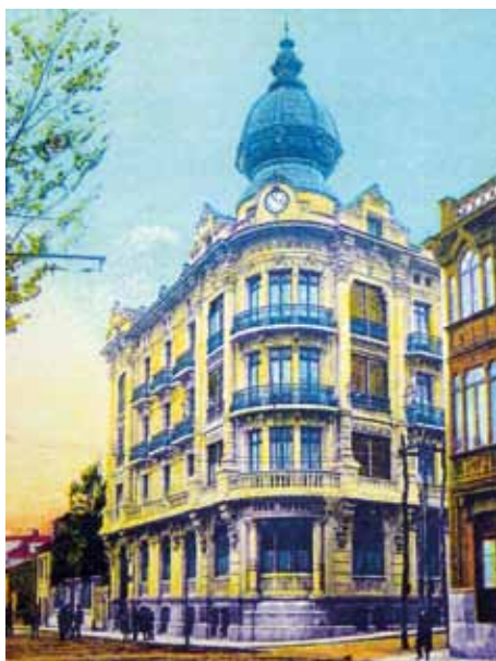
FIGURA 18: Edificio del Gran Hotel, Avilés.
