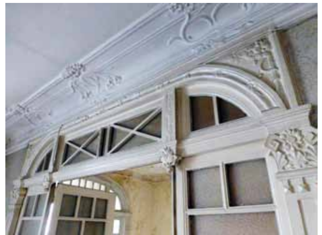
FIGURA 364: Detalle del interior de una de las viviendas.
