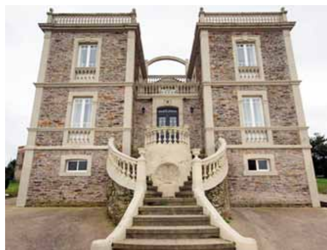
FIGURA 25: Villa Auristela, Villapedre (Navia). Estado actual.
