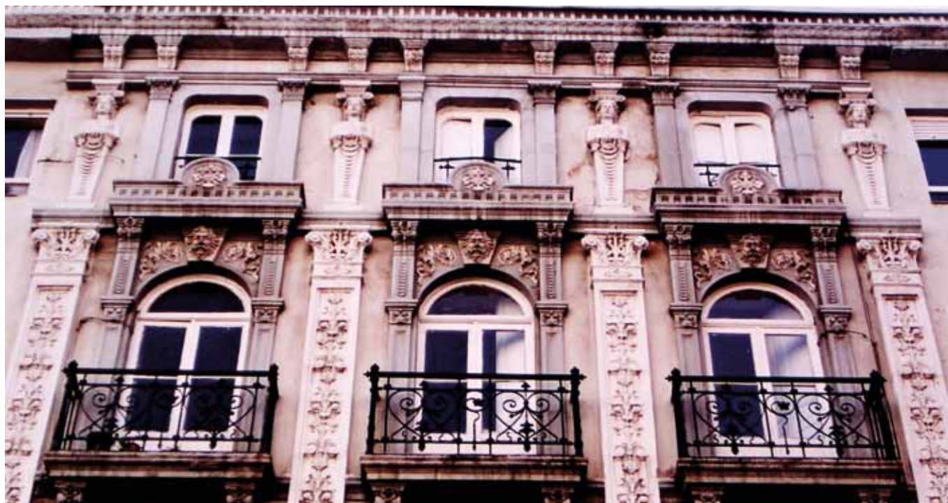
FIGURA 124: Edificio de viviendas en la calle Fray Ceferino, Oviedo. Maestro de obras Ulpiano Muñoz.
