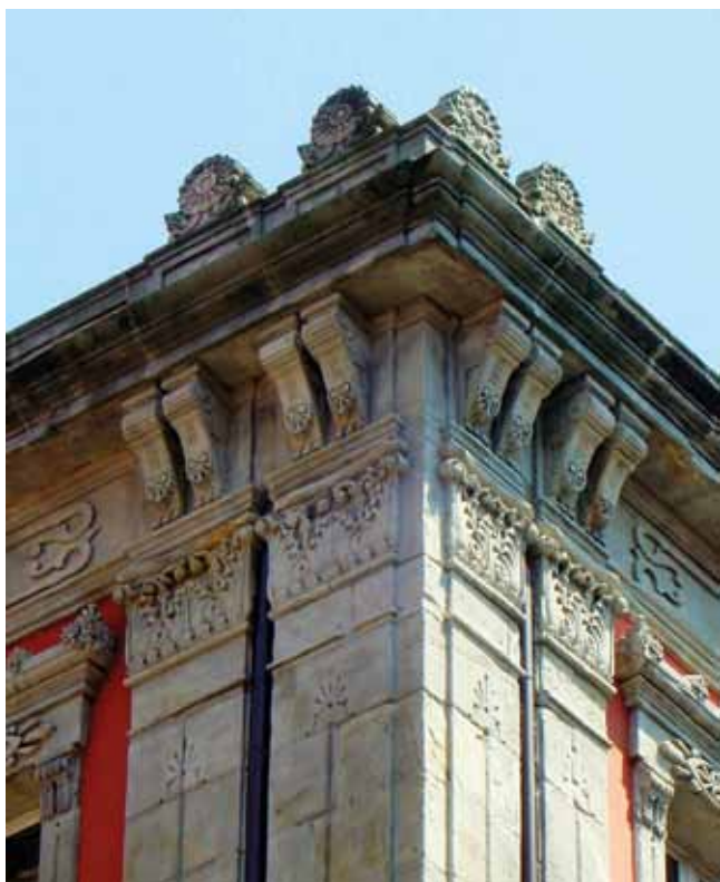
FIGURA 99: Detalle de cantería en edificio de viviendas en Gijón. Maestro de obras Pedro Cabal.
