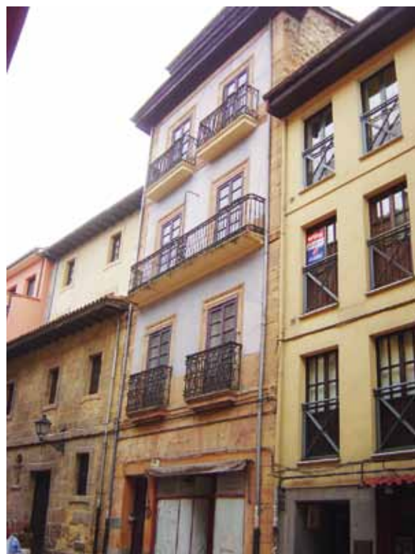
FIGURA 268: Alzado a la calle Magdalena antes del vaciado del edificio.
