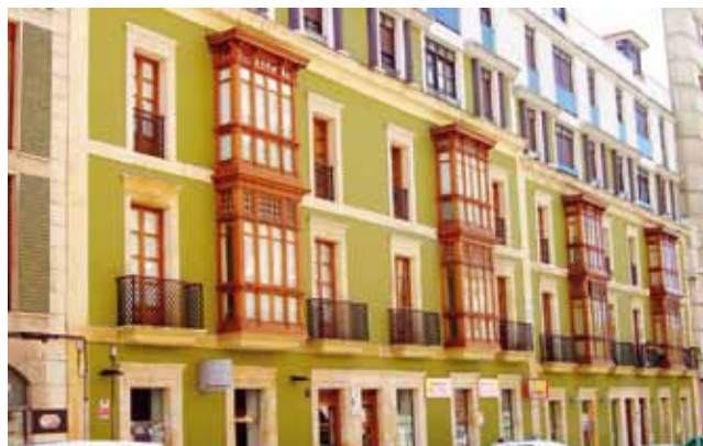
FIGURA 245: Grupo de viviendas conocidas como las Casas de Don Albertón , fachada a la avenida Hermanos Felgueroso, Gijón. (R)
