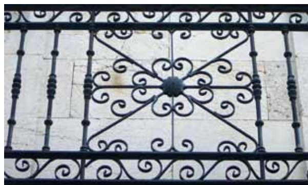
FIGURA 165: Detalle de la rejería del balcón.
