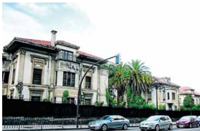
FIGURA 63: Viviendas unifamiliares de la Fábrica de Armas de La Vega, Oviedo.
