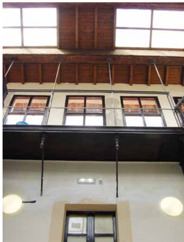
FIGURA 157: Detalle del interior del observatorio.
