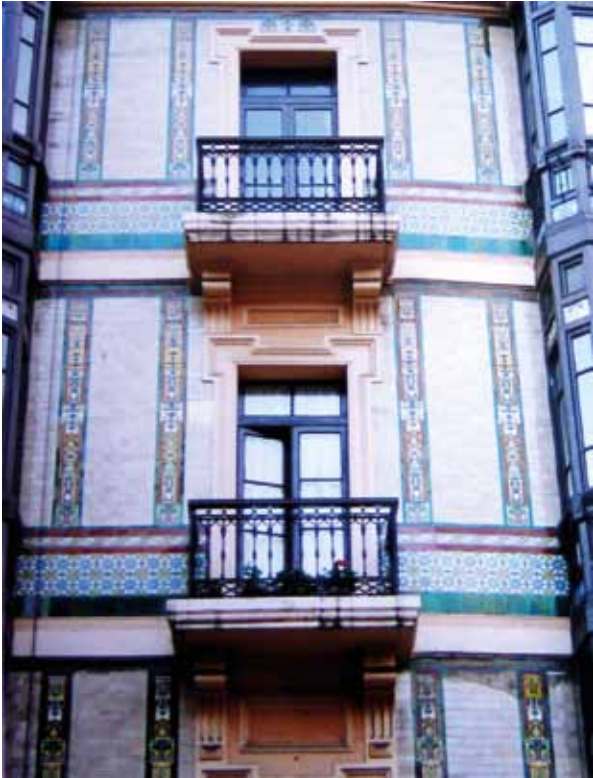
FIGURA 457: Detalle de la fachada.
