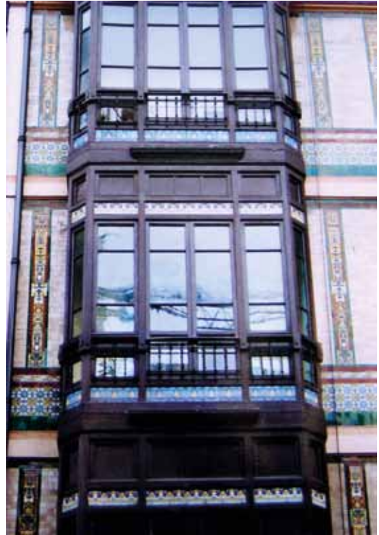
FIGURA 458: Detalle de la fachada.
