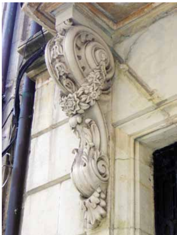
FIGURA 282: Detalle de la fachada.
