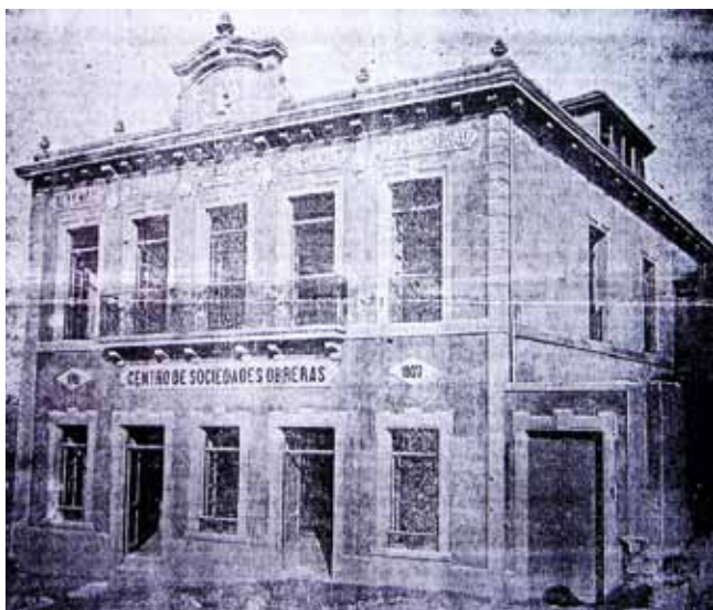
FIGURA 83: Casa del Pueblo de Oviedo.
