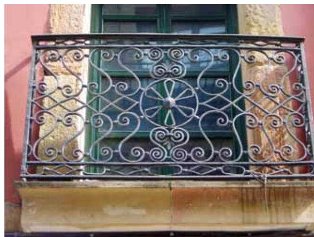
FIGURA 407: Detalle de la fachada.
