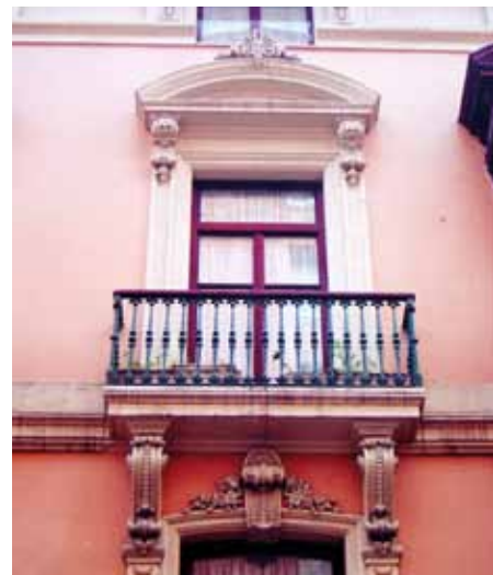
FIGURA 181: Detalle de la fachada.
