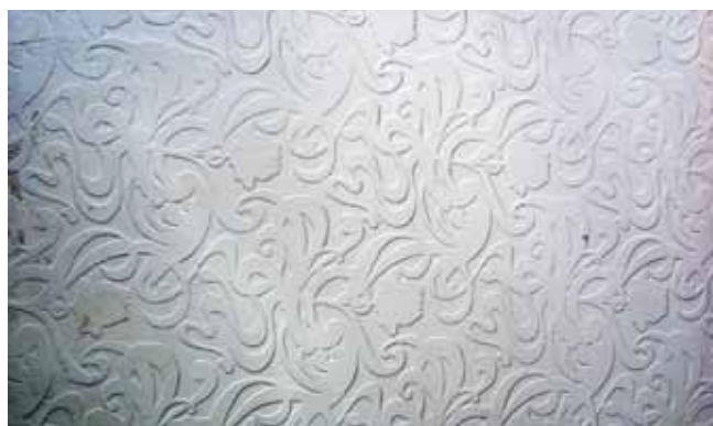
FIGURA 145: Detalle del esgrafiado del portal.
