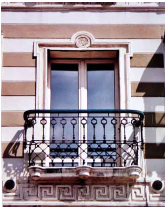
FIGURA 159: Detalle de la fachada.
