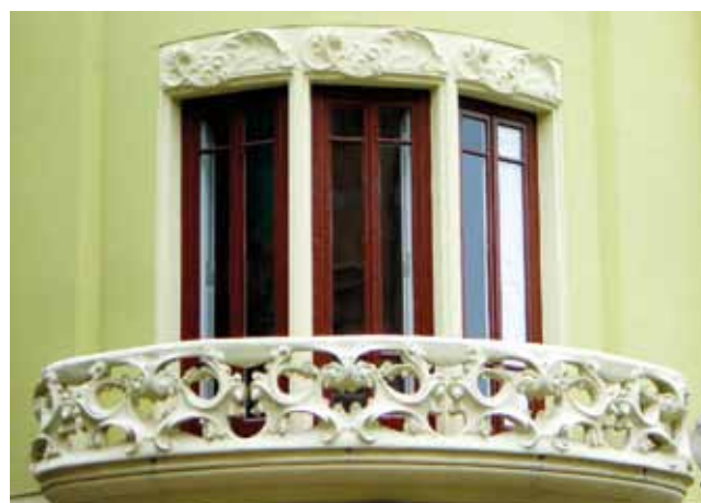
FIGURA 142: Detalle del balcón de la rotonda.
