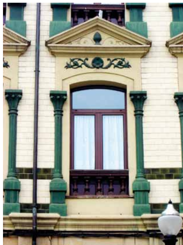
FIGURA 177: Detalle de la fachada.
