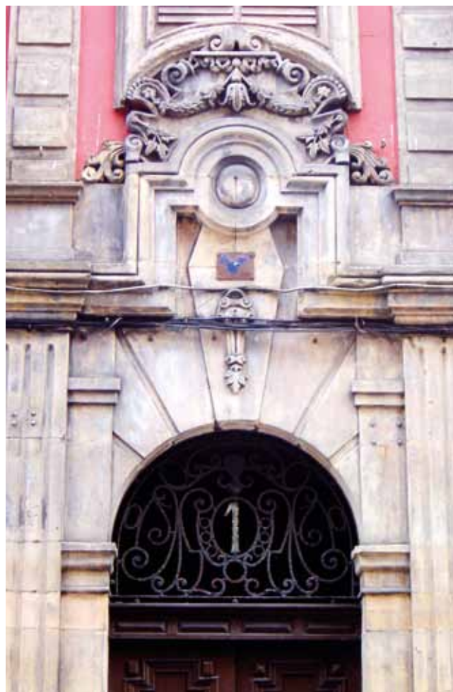
FIGURA 172: Detalle de la fachada.
