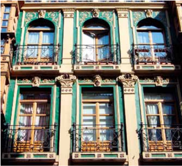
FIGURA 210: Detalle de la fachada.
