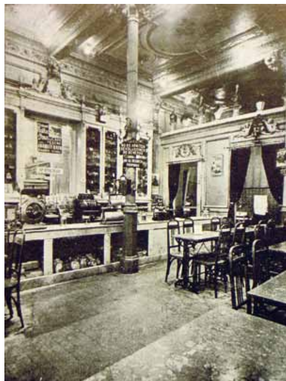
FIGURA 423: Interior de la confitería Casa Rato ubicada en el bajo del inmueble.
