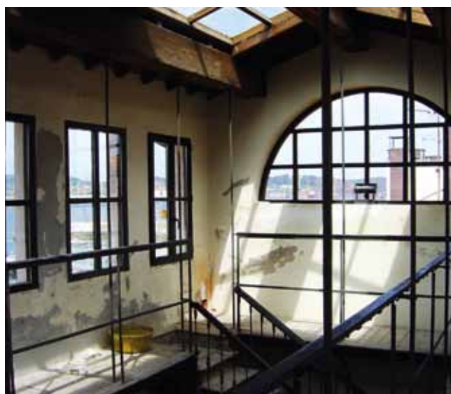
FIGURA 156: Detalle del interior del observatorio.
