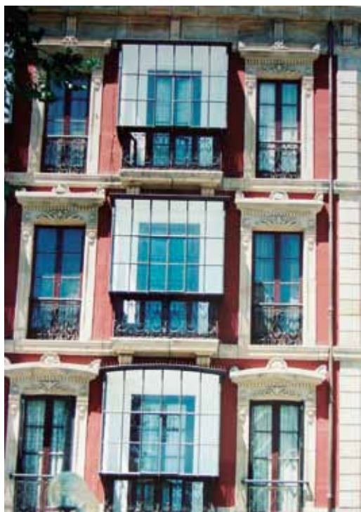
FIGURA 174: Detalle de la fachada a la calle Covadonga.
