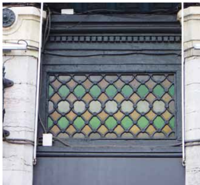
FIGURA 161: Detalle de la fachada.
