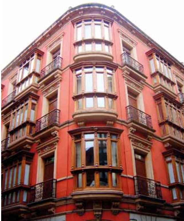
FIGURA 193: Detalle de la fachada.
