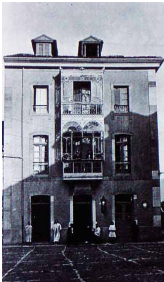
FIGURA 69: Edificio proyectado por Nicolás Casielles, Salas.
