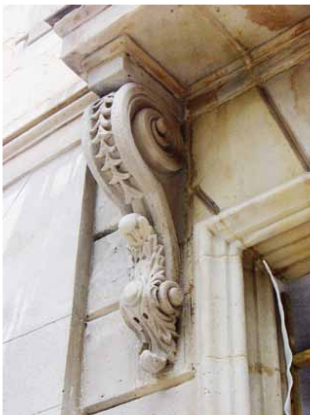
FIGURA 283: Detalle de la fachada del edificio de Cayetano Menéndez Bandujo.
