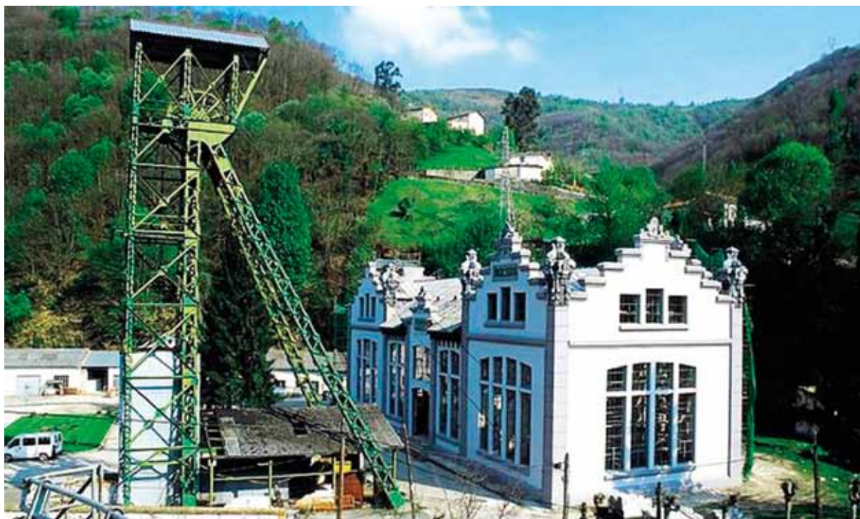
FIGURA 49: Pozo San Luis, La Nueva (San Martín del Rey Aurelio).
