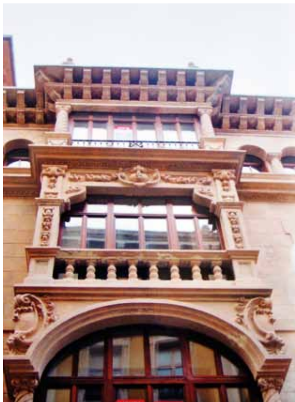
FIGURA 443: Detalle de la fachada.
