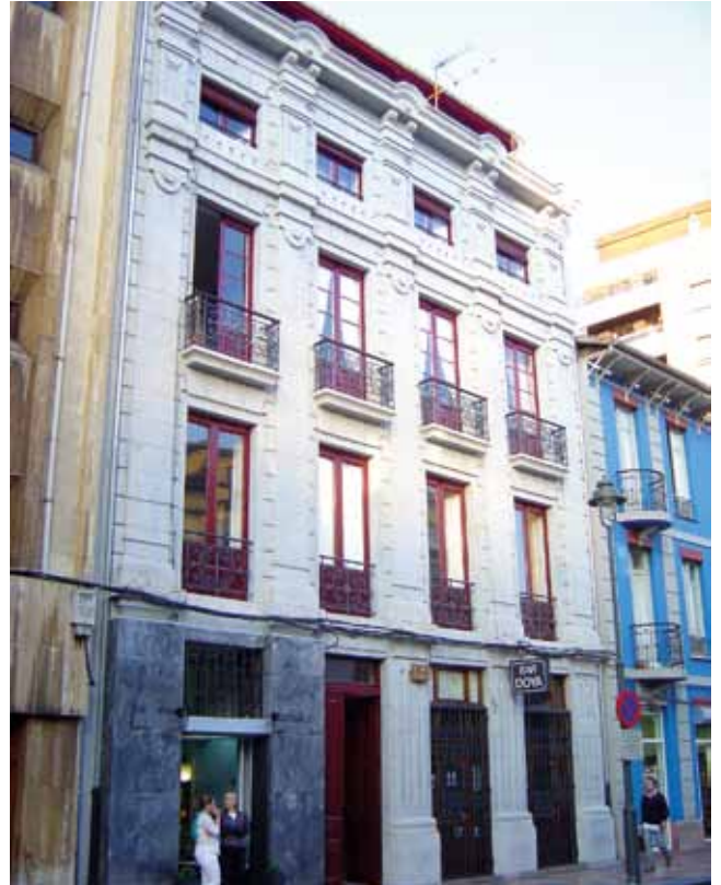
FIGURA 77: Edificio en la calle Pedro Menéndez, 10, Avilés.
