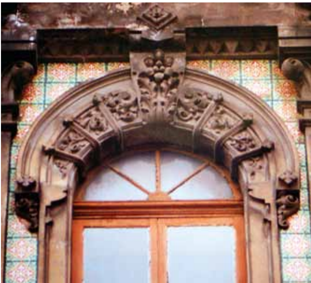
FIGURA 212: Detalle de la fachada.
