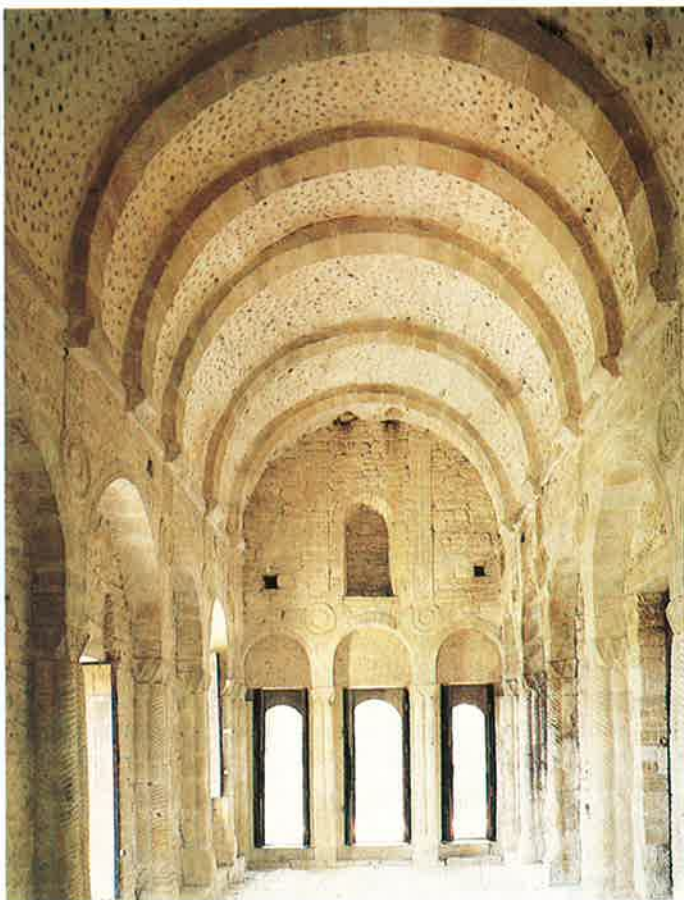
Santa María del Naranco. Vista general del interior del piso alto.
