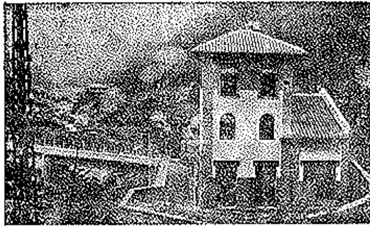
Vista parcial de la Central Eléctrica S. A. «Electro Canguesa» (Rio Seña)
